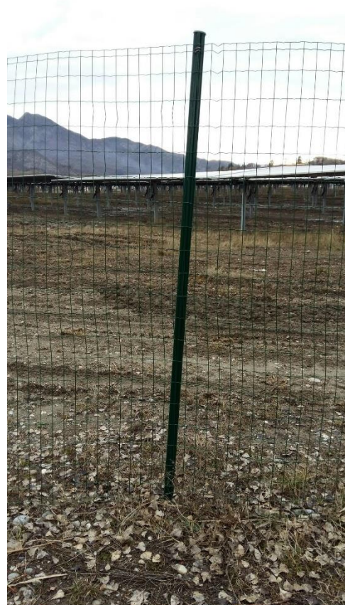
Figure 47 : Exemple de clôture autour d'une centrale (Source : AKUO)
